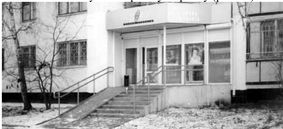
Рис. 66. Ненормативный пандус опасный для незрячих и слабовидящих.
